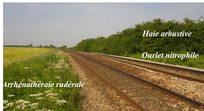
Aperçu de la voie ferrée
